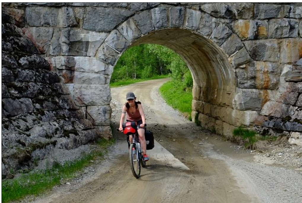
Jernbaneundergang. Foto: Carl Norberg (2016)
