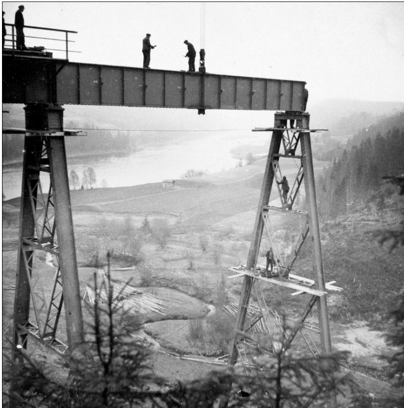
Trolldalen viadukt. Foto: Norsk jernbanemuseum (1938)
